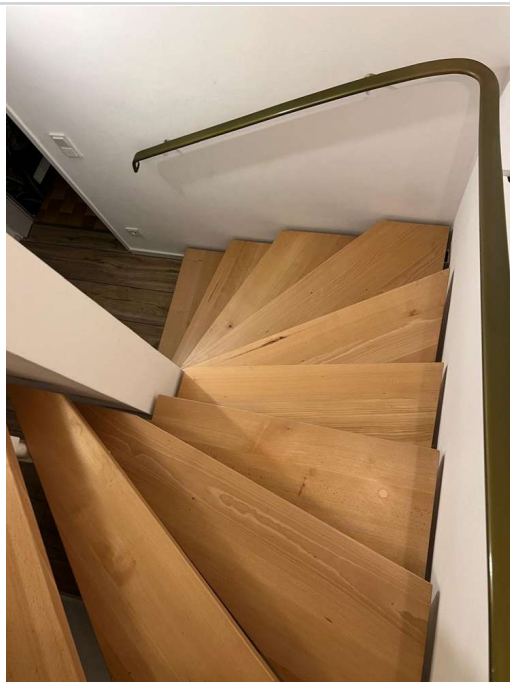
Treppe zum Soutterrain
